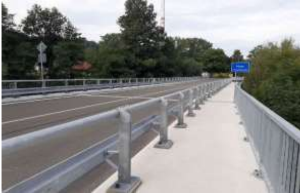
Most 2379-004 (M63) Nemecká, po rekonštrukcii 08/2021
