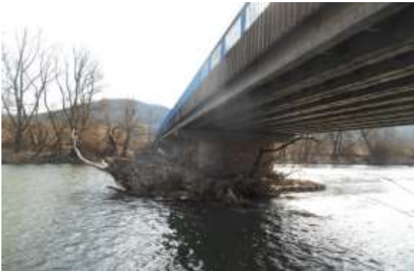
Údržba most 2511-02 (M5848) Tekovská Breznica
