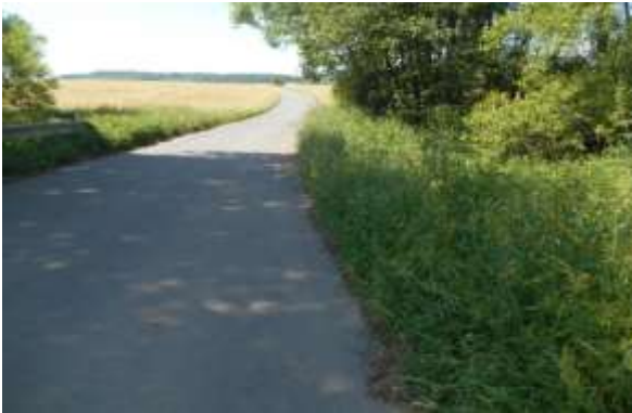
Údržba most 1587-06 (M6024) Prenčov
