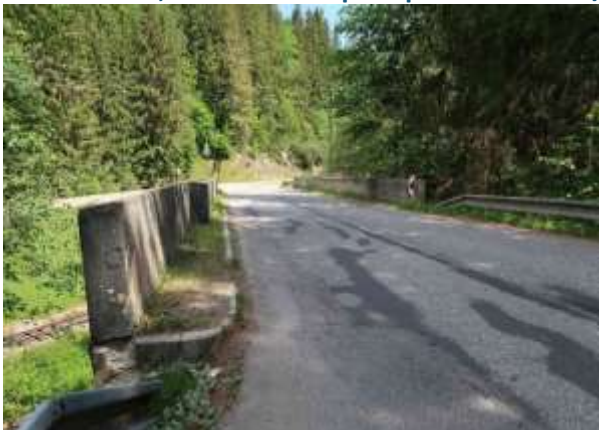
Most M4828, ev.č. 529-009 pred prestavbou 06/2022
