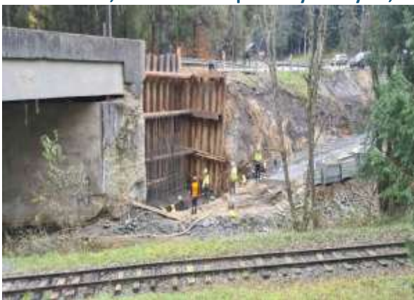
Most M4828, ev.č. 529-009 počas výstavby 09,10,11,12/2022
