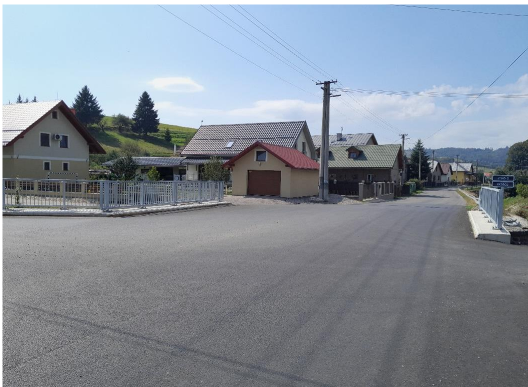
Most M2802, ev. č. 2395-005, po realizácii rekonštrukcie
