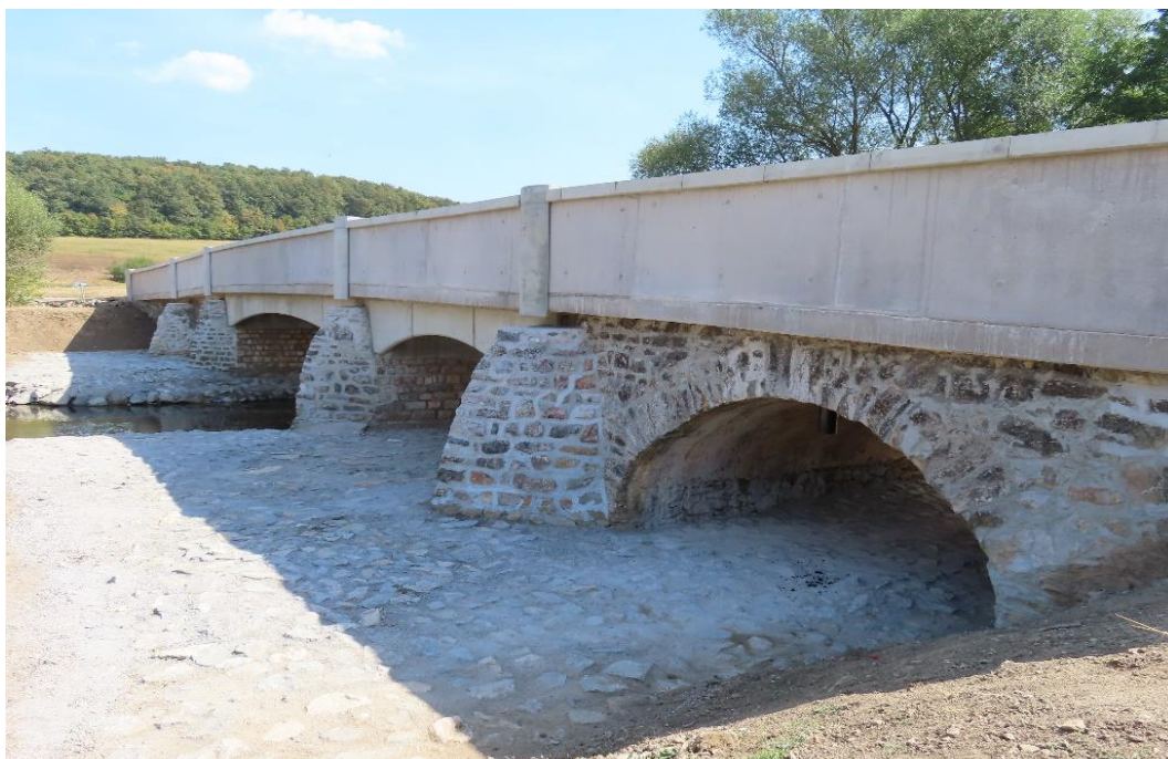
Most M1296, ev. č. 2837-004, po realizácii rekonštrukcie
