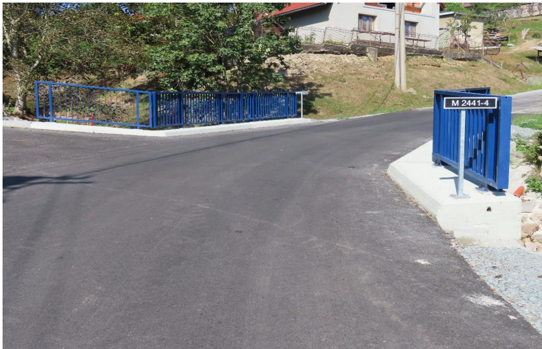
Most M4563, ev. č. 2441-004, po realizácii rekonštrukcie
