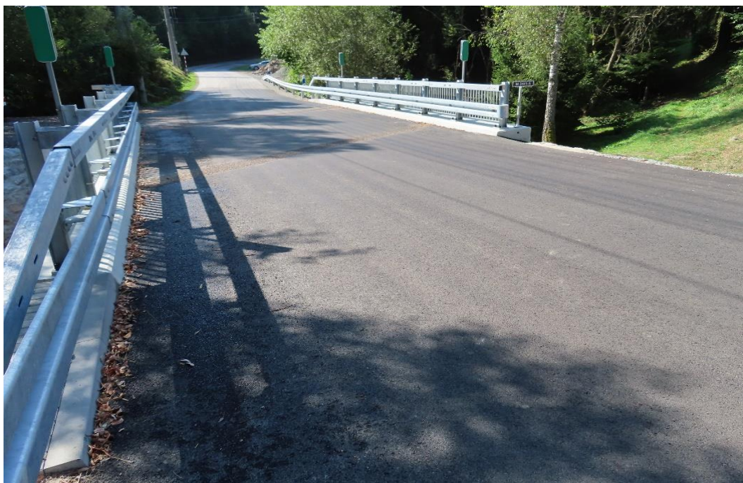
Most M1826, ev. č. 2441-005, po realizácii rekonštrukcie
